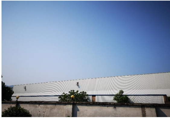
西南侧临近摄影棚
