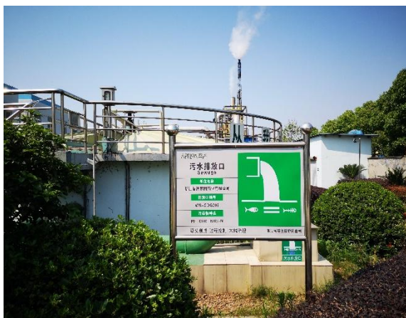
废水纳管排放口
