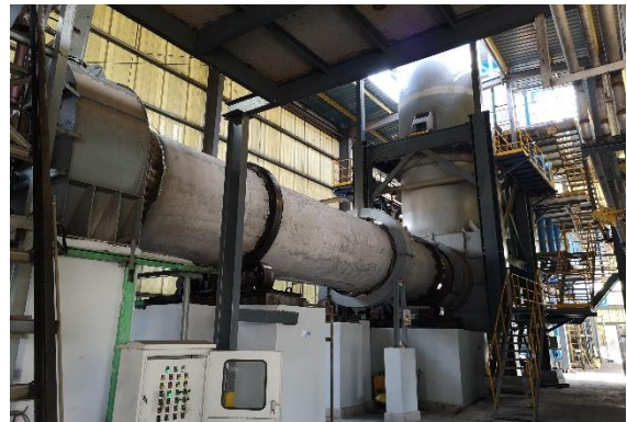
项目拟建区域（危废焚烧炉）
