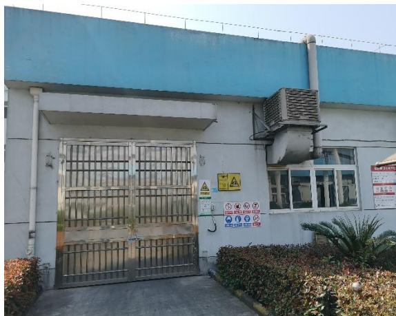
危废暂存库外景
